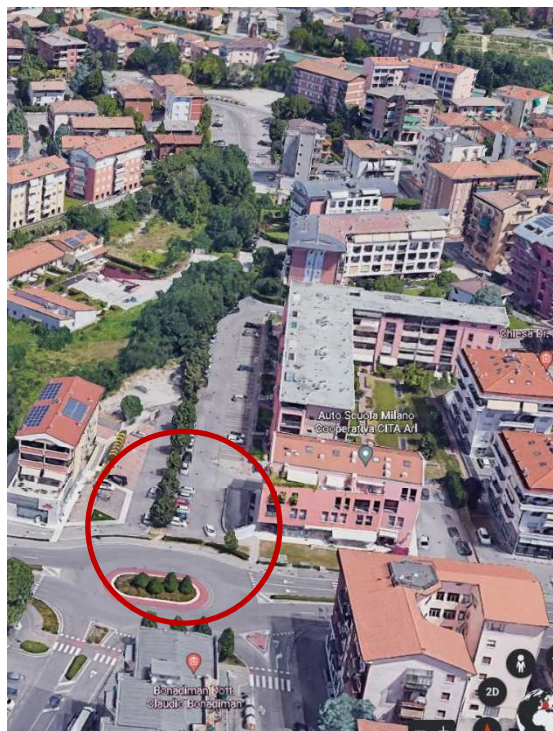
PUA 418 – Vista aerea stato dei luoghi – lato VIA FIUMI
